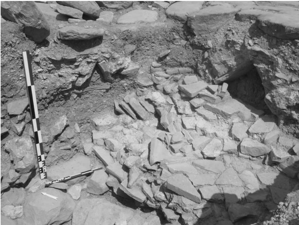
Fig. 7 – Il parziale ripristino del condotto fognario che corre sotto uno degli assi principali della città romana di Ostra (Ostra Vetere-AN)
